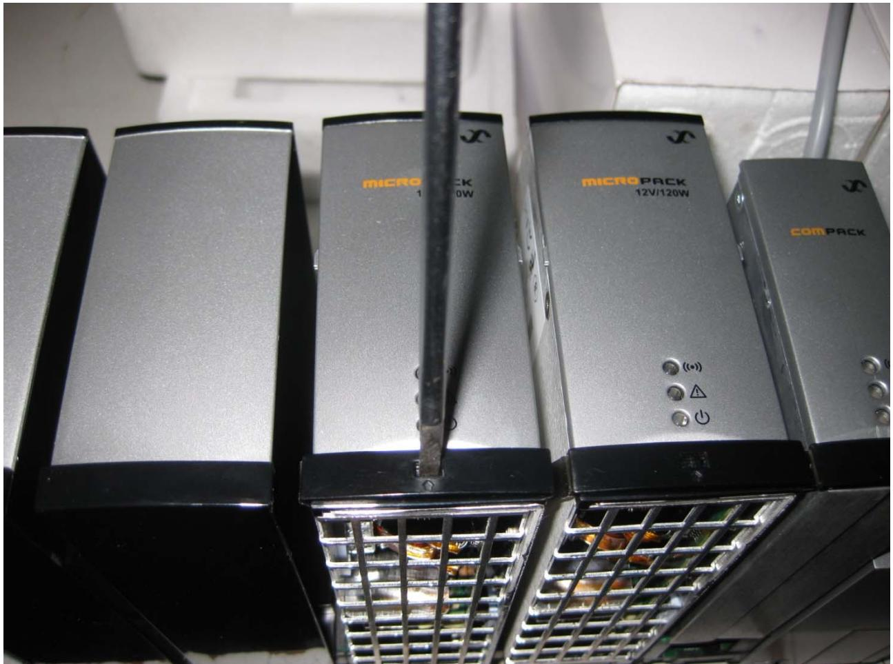
Figure 24. Module Removal
